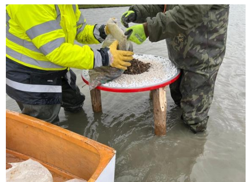
Aanleg van de broedplatforms.
